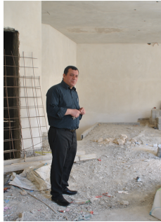
Dr A. Abousour directeur d'Alrowwad dans le chantier du centre de formation professionnelle
