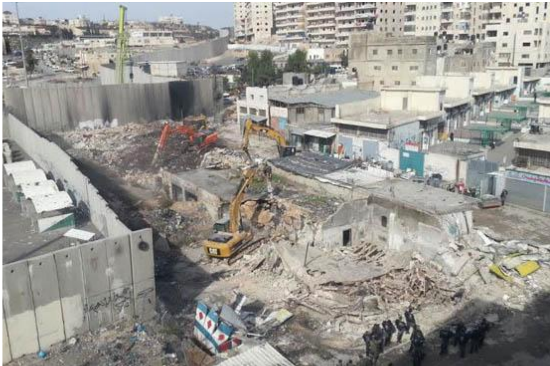
Shu'fat –(banlieue Nord de Jérusalem) Les bulldozers israéliens démolissent les magasins commerciaux et un bâtiment pour l'extension du mur d'annexion
